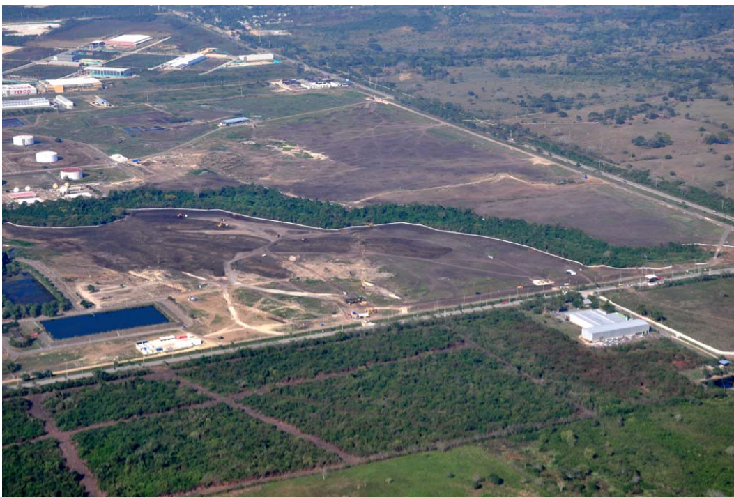
Foto 2. Vista aérea del área del proyecto.
