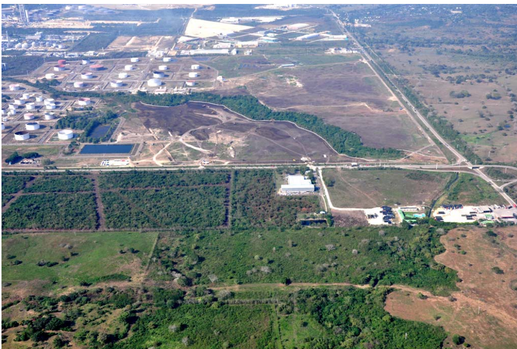
Foto 1. Vista aérea del avance de los trabajos de limpieza del área del proyecto.
